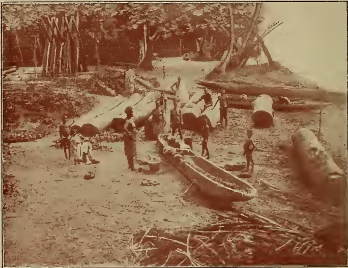
Chantier d'acajou à Moossou (Côte d'Ivoire.)
